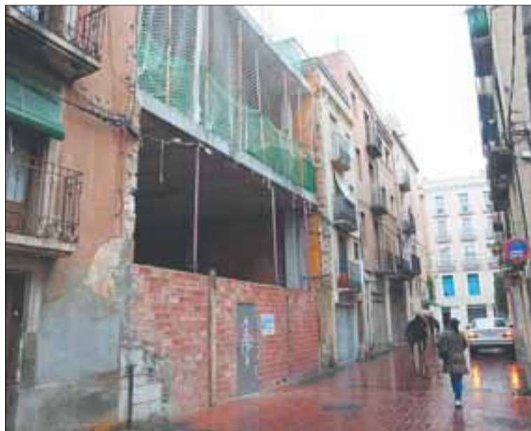
Imagen del estado actual de las obras de la Escola de Música i Conservatori de la Diputació de Tarragona. FOTO: ALBA MARINÉ
