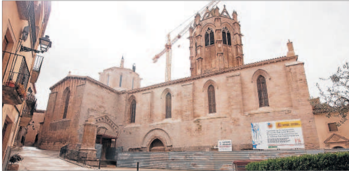
Imatge recent del monestir de Vallbona de les Monges, amb una grua però ja sense bastides a la façana.
