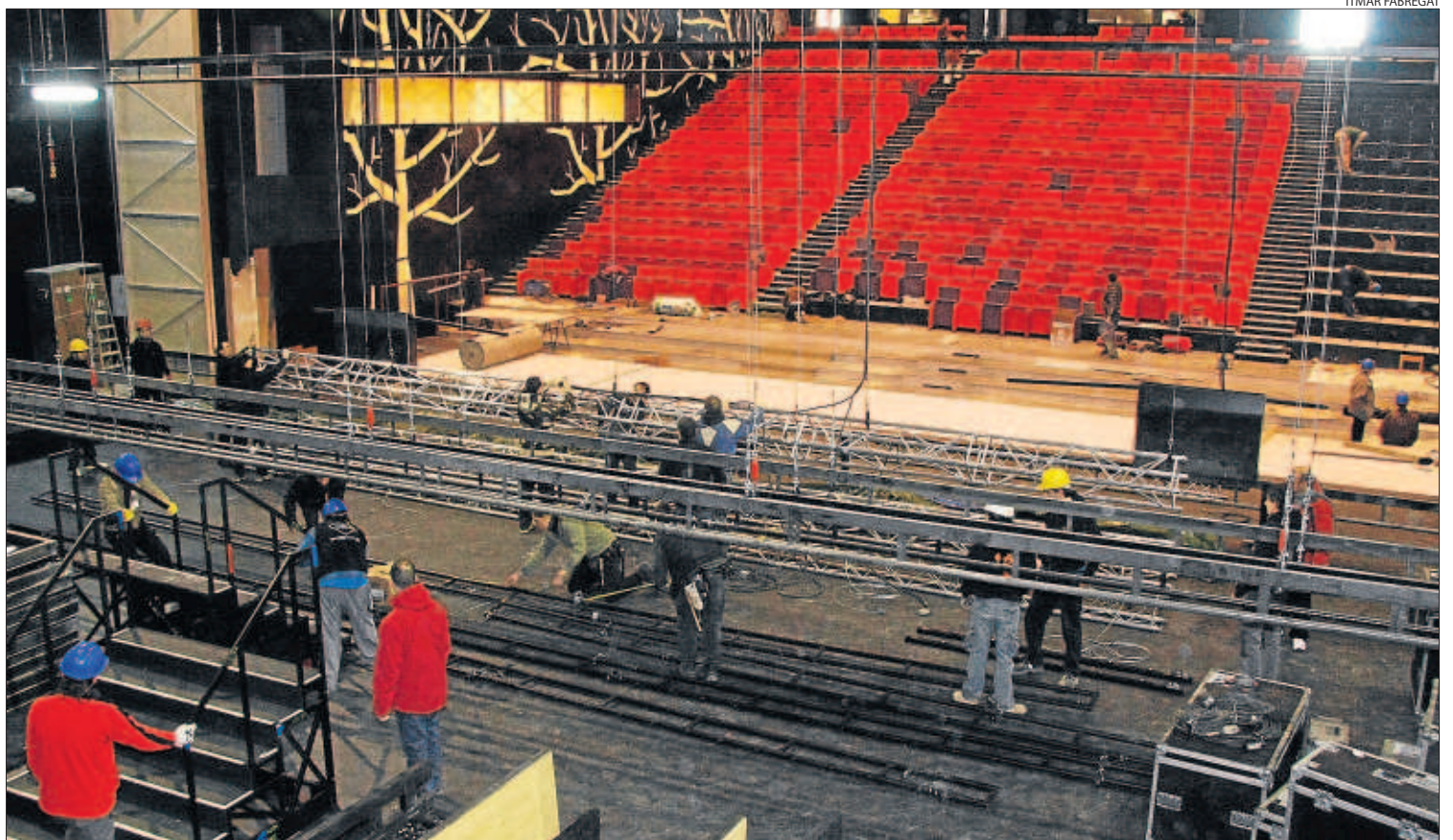
Los operarios iniciaron ayer las instalaciones de iluminación, monitorización y escenografía para la ópera 'Il Trovatore' que inaugurará La Llotja.
